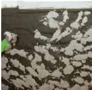
Aufbringen eines Spritzbewurfes aus KÖSTER Sanierputz
