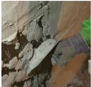
Aufbringen des KÖSTER Sanierputzes
