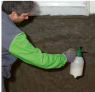
Grundieren mit KÖSTER Polysil TG 500
