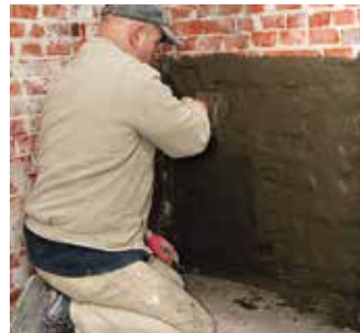
4 KÖSTER Kellerdicht 1 Schlämme: 2 Anstriche (zweite Lage nach 30 Minuten)
