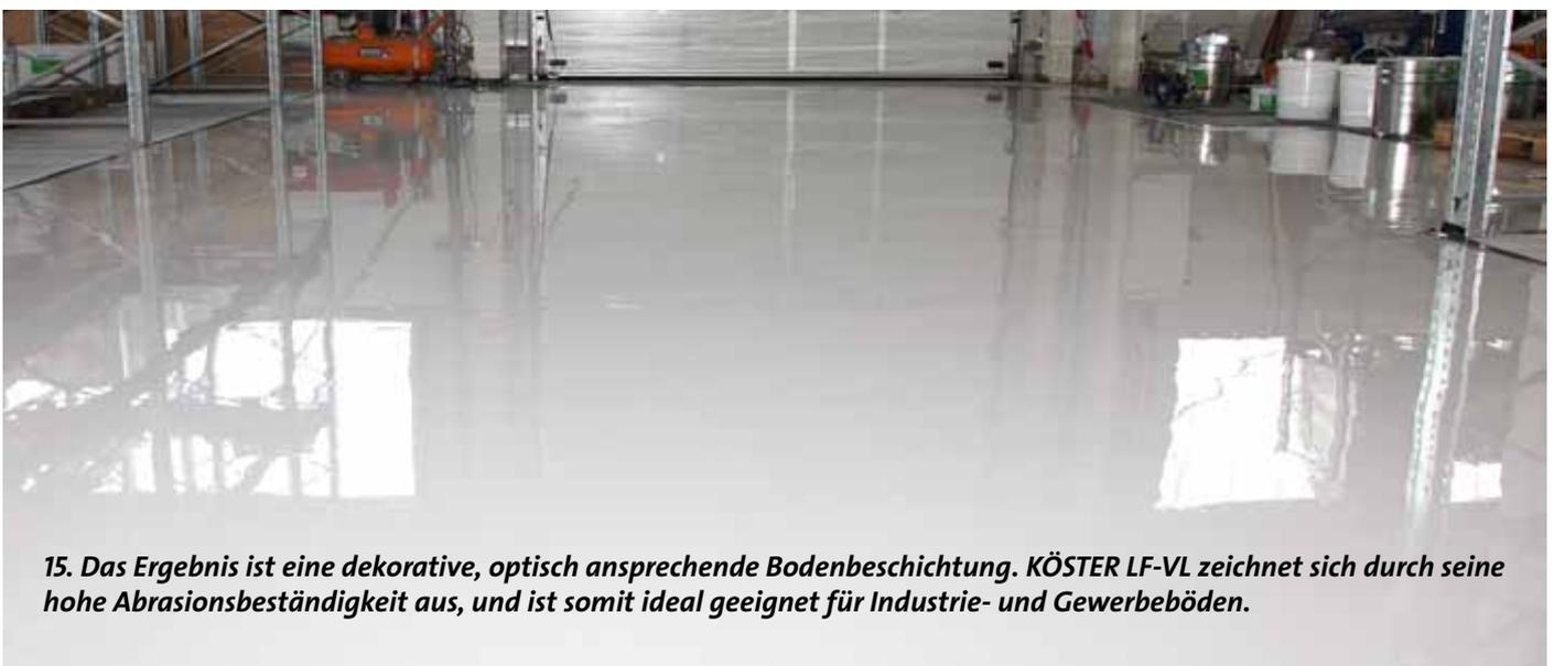
15. Das Ergebnis ist eine dekorative, optisch ansprechende Bodenbeschichtung. KÖSTER LF-VL zeichnet sich durch seine hohe Abrasionsbeständigkeit aus, und ist somit ideal geeignet für Industrie- und Gewerbeböden.
