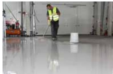
13. Nachdem das Material auf den vorbereiteten Untergrund gegeben wurde, kann KÖSTER LF-VL mit Hilfe eines geeigneten Glättwerkzeugs gleichmäßig verteilt werden. Das Material ist selbstnivellierend.
