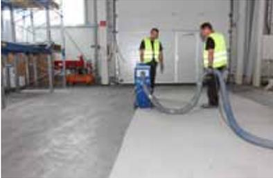
**1. Die Untergrundvorbereitung erfolgt per Strahlverfahren mit festem Strahlgut. Durch diesen Prozess werden alte Beschichtungen und haftungsmindernde Verunreinigungen entfernt.**
