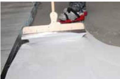
12. Die Verarbeitung auf dem mit KÖSTER LF-BM vorgestrichenen Untergrund erfolgt in mindestens einer Auftragslage. Der Verbrauch beträgt ca. 1,3 kg/m<sup>2</sup> je mm Schichtstärke.
