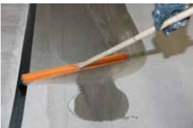
**7. Die Grundierung erfolgt durch eine Lage KÖSTER LF-BM. Ist eine rückwärtige Belastung durch Wasserdampf und/oder hoher Alkalität zu erwarten, wird KÖSTER VAP 2000 als Voranstrich verwendet.**
