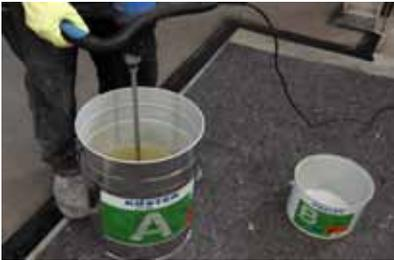
10. Deckbeschichtung mit KÖSTER LF-VL: Die B-Komponente wird mit einem langsam laufenden Rührwerk in die A-Komponente eingerührt. Die Mischzeit beträgt 3 Minuten.
