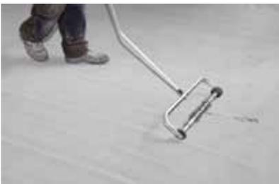
**4. Erfolgt die Untergrundvorbereitung per Strahlverfahren mit metallischem Strahlgut, wird die Oberfläche mit einer Magnetwalze gereinigt. Das aufgenommene Material lässt sich wiederverwenden.**
