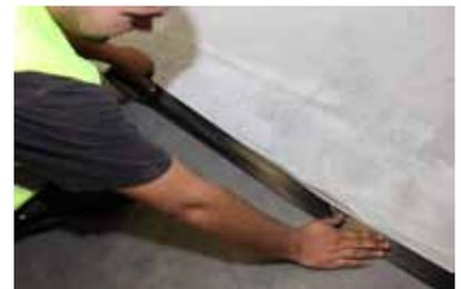
**6. Die Seitenränder der zu bearbeitenden Fläche werden abgeklebt, so lassen sich saubere Kanten herstellen und Bereiche vor Material- einwirkung schützen.**
