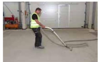
**9. Nach dem Aushärten der Grundierung wird überschüssiges Streugut abgesaugt.**
