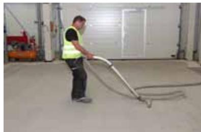
**5. Um einen idealen Haftverbund zwischen Untergrund und Beschichtung herzustellen, werden Staub und lose Bestandteile von der Oberfläche abgesaugt.**
