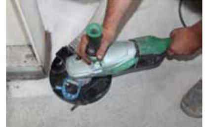
**3. Bei allen Details, wie beispielsweise Ecken und Kanten, ist ebenso eine mechanische Untergrundvorbereitung durch Abfräsen der Oberfläche erforderlich.**
