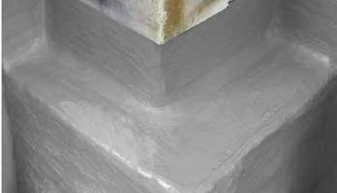
Fuß- und Sockelabdichtung
